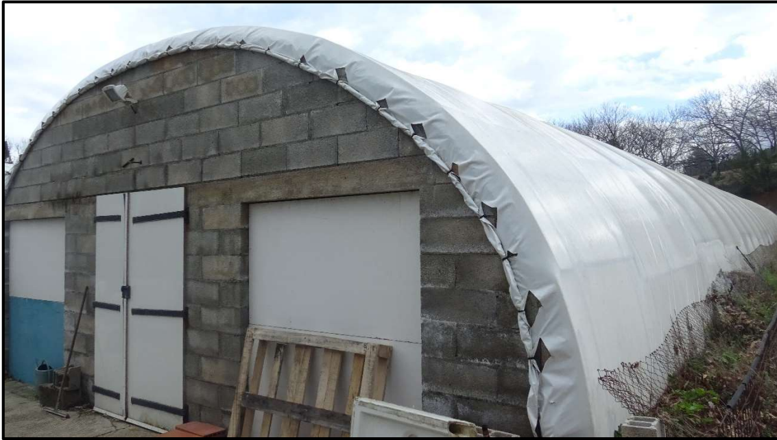
Figure 4 : La serre, vue de l'extérieur. On voit de part et d'autre de l'entrée des ouvertures fermées : il s'agit du système de refroidissement par évaporation de l'eau
