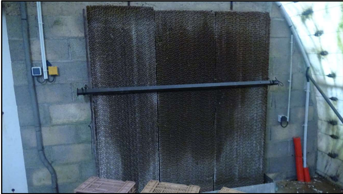
Figure 5 : Système de refroidissement par évaporation de l'eau : un carton imbibé d'eau par une pompe
